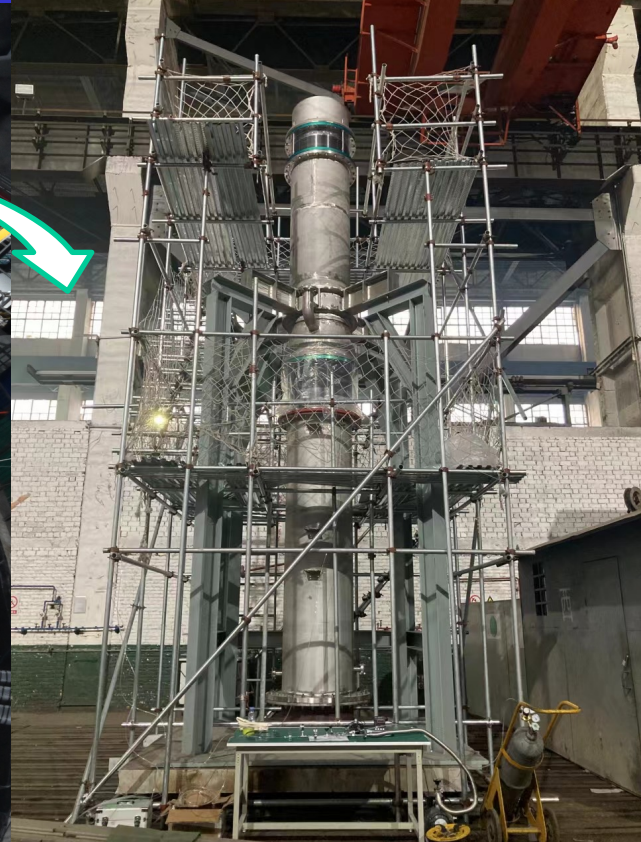
Chimney: 8.85 meter high
